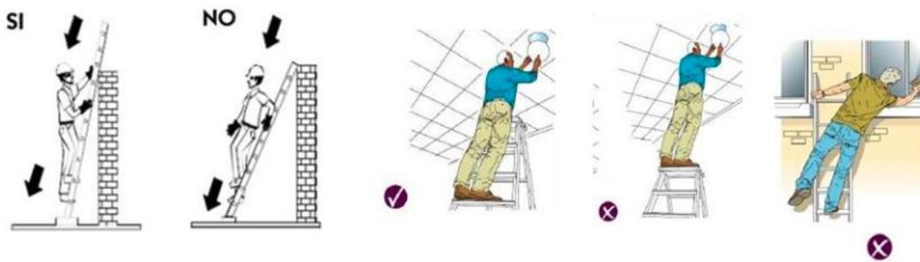
Ilustración 4 - Procedimiento de Ascenso y Descenso de Escaleras
