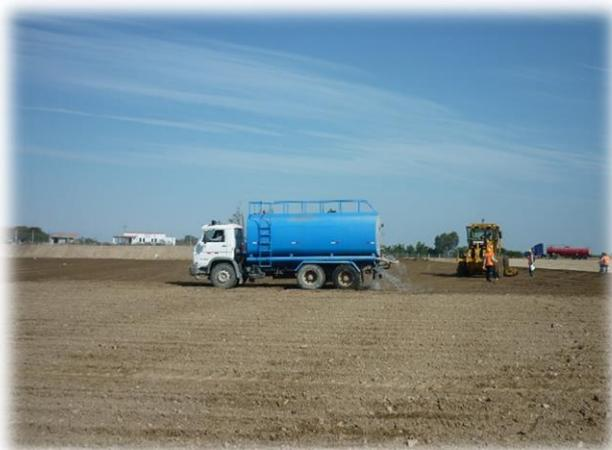
C.2 Escarificado: Consiste en remover la tierra con una profundidad de 20 cm con medios mecánicos.
