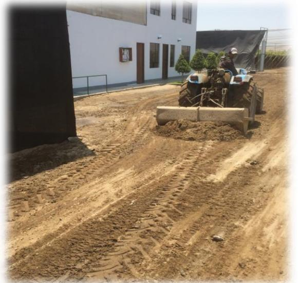
C.5 Nivelado del tramo: Se compacta el terreno para tener una vía uniforme para el tránsito de vehículos.
